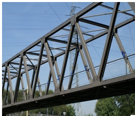
Passerelle pour vélos (Allemagne)
