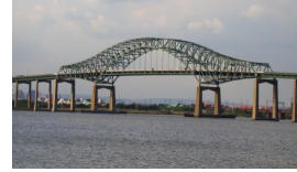
Hart bridge (ETATS UNIS)
