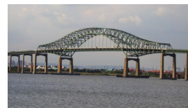
Hart bridge (ETATS UNIS)
