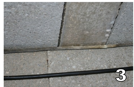
Isolation par feutre bitumé entre le soubassement et le plancher
