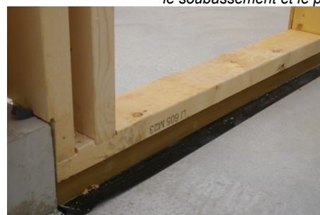
Construction à ossature bois – semelle sur feutre
